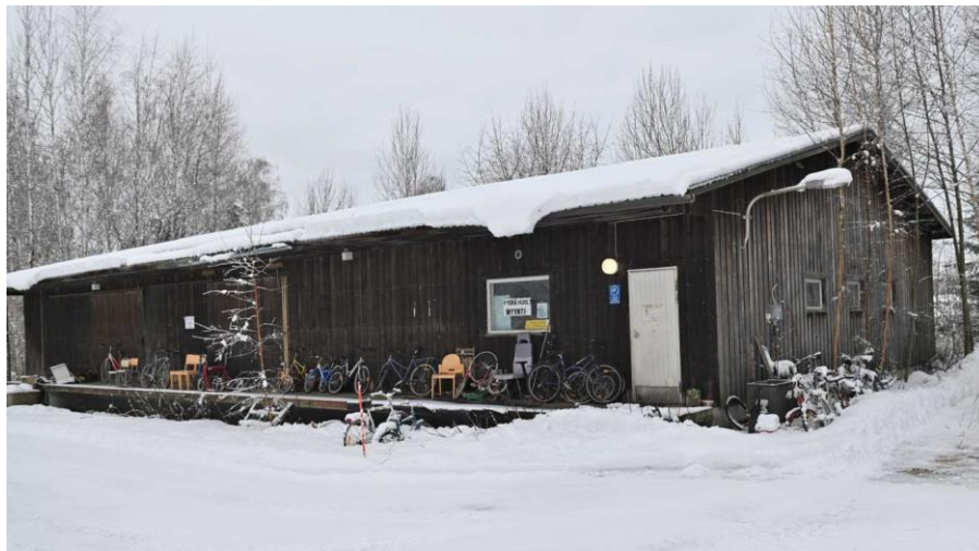
Kuva: Varastorakennus, jossa on toiminut mm. pyöräkorjaamo.
