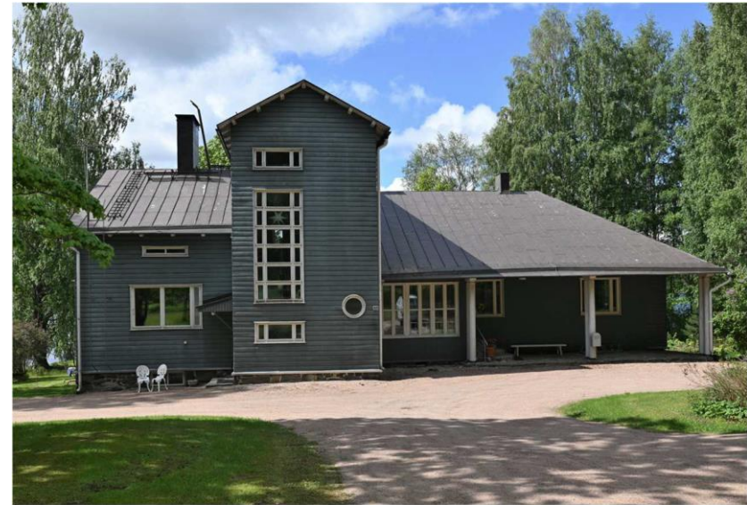
Kuva: Päärakennuksen julkisivu kirkon suuntaan.
