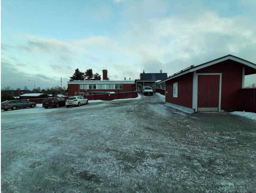
Kuva 15. Kuvassa näkyy entinen Ristiinan päiväkotirakennus ja sen pysäköintialuetta eteläpuolelta katsottuna.
