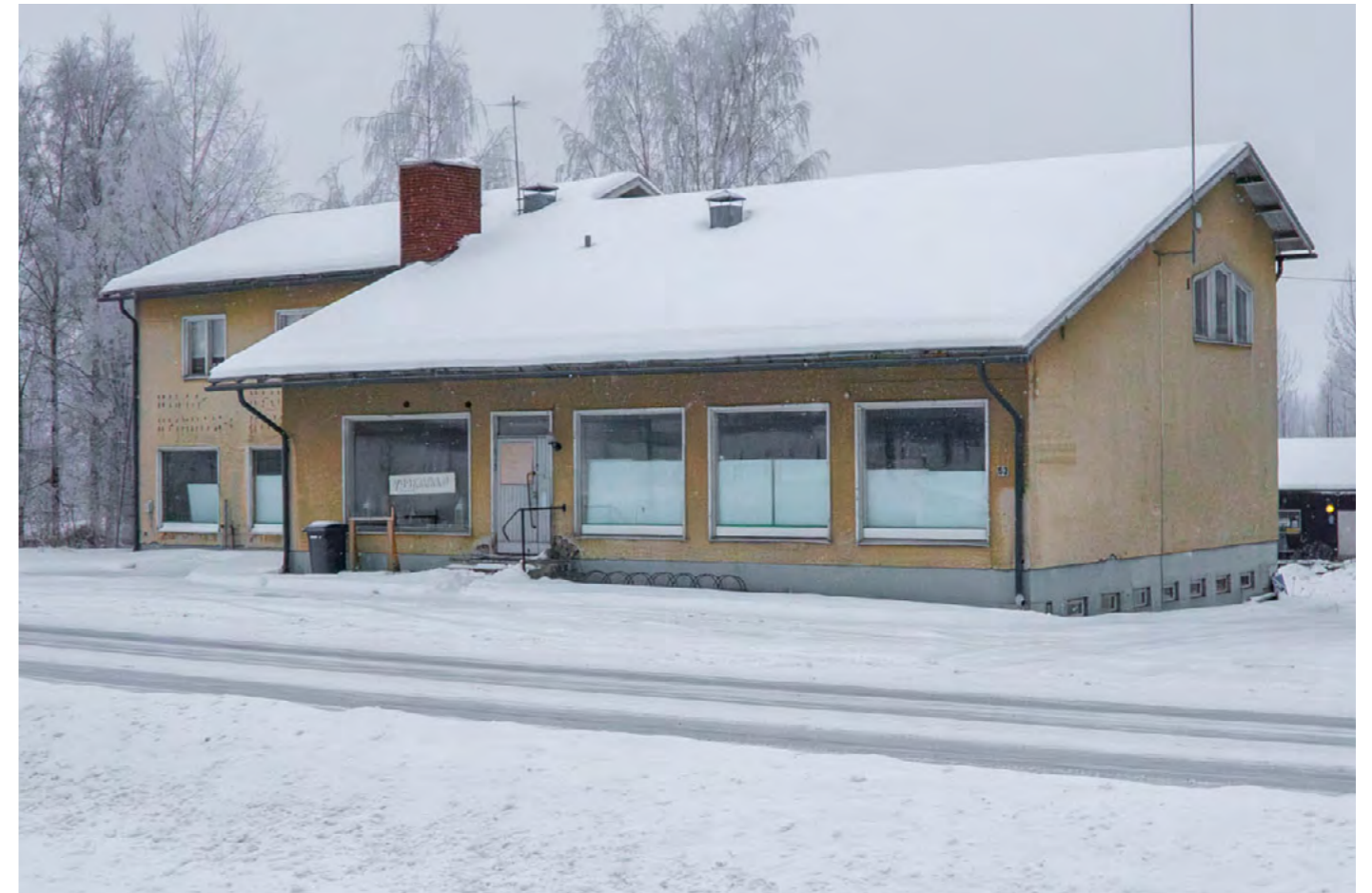
Kuva 12 Rakennuksen 1950-luvulta säilyneet ominaispiirteet tulee säilyttää muutos- ja korjaustyöissä. Kuva Tengbom/joulukuu 2023.
